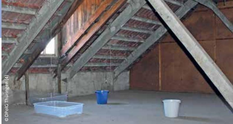
› Auf dem gesamten Dachboden sind Gefäße zum Auffangen des Regenwassers aufgestellt.
