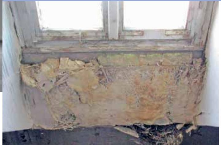
> Fenster und Mauerwerk in den Dachgauben verrotten zusehends.
